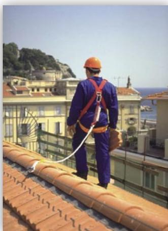
L'enorme vantaggio che da questo tipo di anticaduta è che permette all'operatore di lavorare anche in prossimità di bordi, in quanto si può dare origine ad un sistema di trattenuta.
