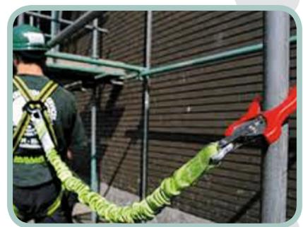
**Connettore per l'ancoraggio** (vedi 10.2.5 "Connettori"): è utilizzato per collegare l'elemento di collegamento al punto di ancoraggio (ad esempio: fettuccia, cavo d'acciaio, pinza) deve essere adeguato al punto di ancoraggio ed avere una resistenza statica (rif. EN 362).
